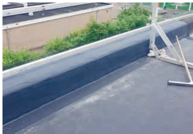
Langs alle dakranden is mechanisch bevestigde kimfixatie aangebracht.
