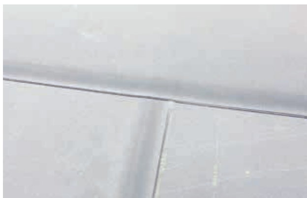
Thermisch gelaste naden.
